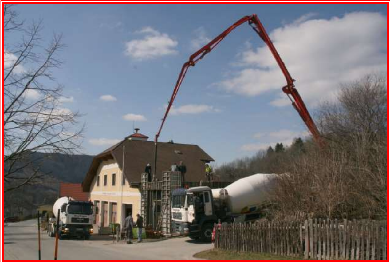
März 2011 - Umbau des Feuerwehrhauses
